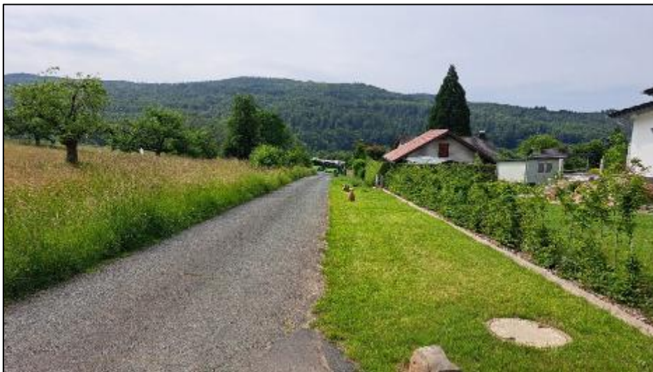
Abb. 5: Auszubauender Asphaltweg auf der Ostseite des südlich angrenzenden Wohngebiets. © Planungsgruppe Prof. Seifert.
