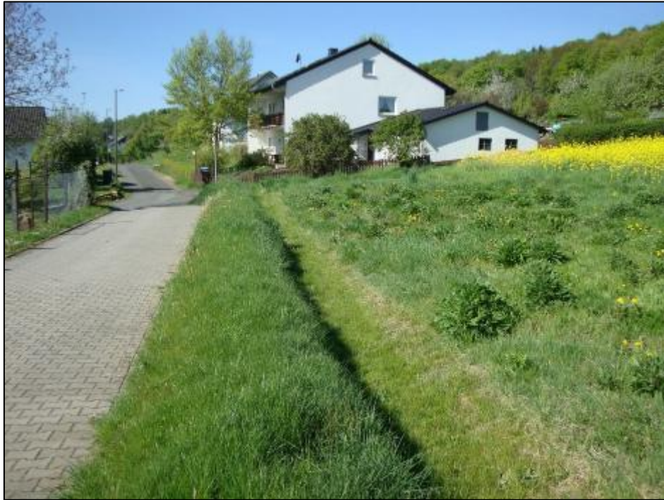
Abb. 2: Böschung mit Ansaatwiese und trockenem Rückhaltegraben am Südostrand. © Planungsgruppe Prof. Seifert.
